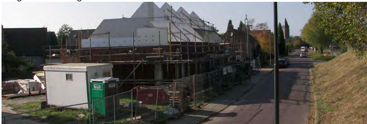
Het Coudorps hofje in aanbouw
